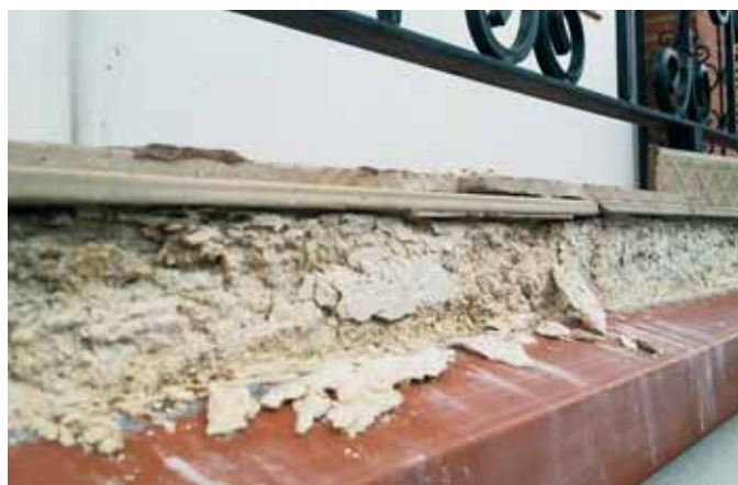
Bardzo słaby materiał podłoża.
