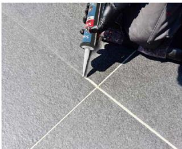
17 Wypełnić szczeliny dylatacyjne.
