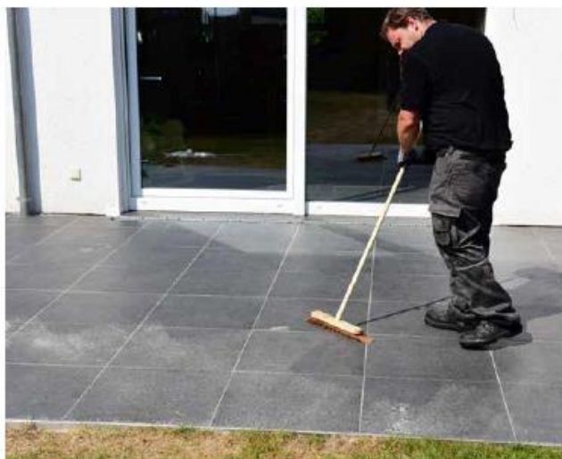
16 ... a resztki zaprawy zmiąć.
