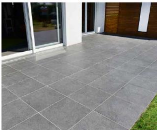
18 Zafugowana powierzchnia osiąga możliwość chodzenia po ok. 24 godzinach.
