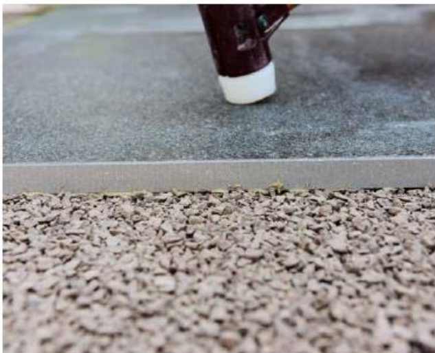
7 Płytę ułożyć i osadzić przy pomocy gumowego młotka.
