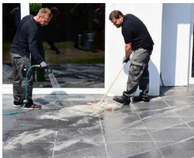
12 Materiał zmoczyć strumieniem wody do powstania plastycznej konsystencji ...
