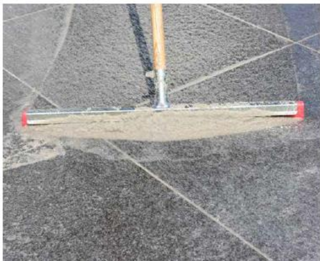
13 ... i przy pomocy gumowej rakli wprowadzić w szczeliny spoinowe.
