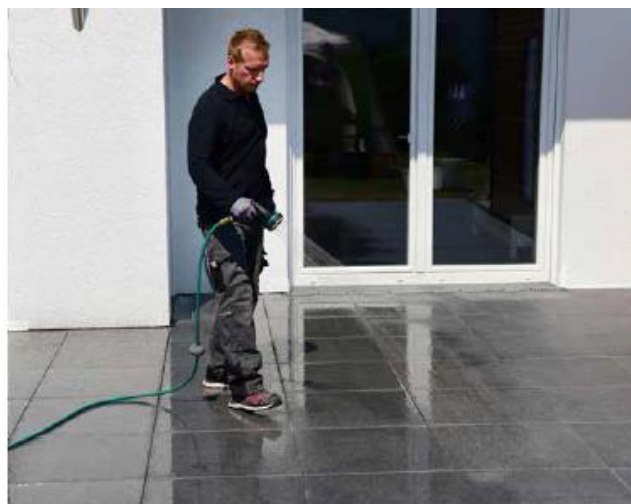
10 Przed fugowaniem dokładnie zmoczyć powierzchnię okładziny i utrzymywać ją w stanie wilgotnym.
