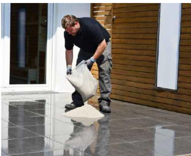
11 Fugę Sopro Solitär® F20 wyłożyć na okładzinę.
