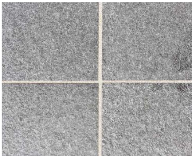
19 Wygląd okładziny zaspoinowanej fugą Sopro Solitär® F20.
