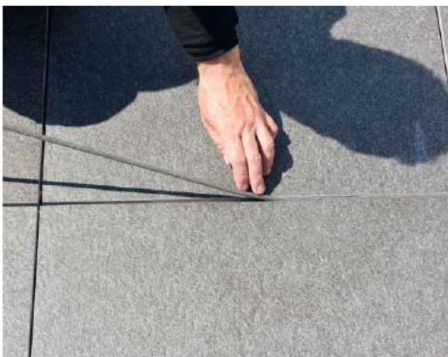
9 Zaprojektowane szczeliny dylatacyjne wypełnić szczelnie przylegającym sznurem dylatacyjnym Sopro PER 567.
