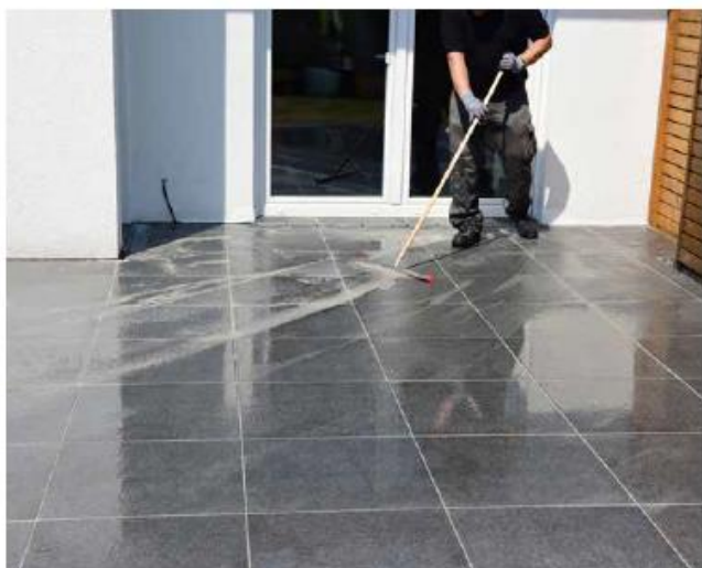
15 Nadmiar zaprawy fugowej usunąć ...
