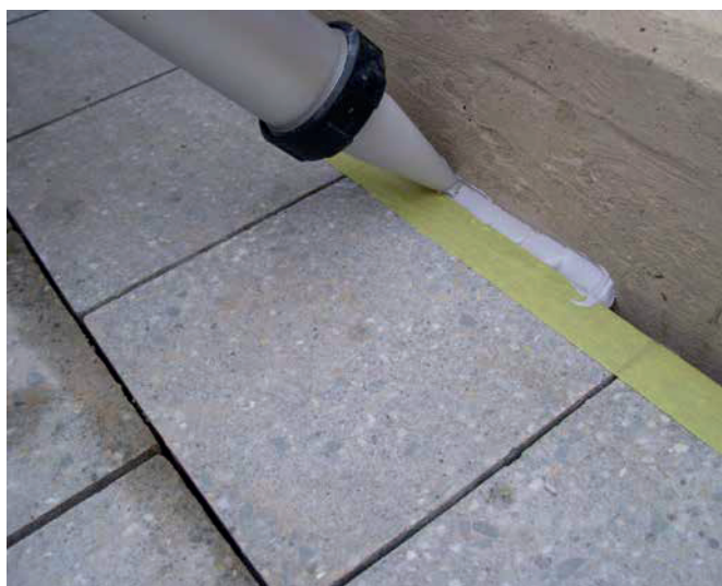
3 Fugą Sopro PUD 682 wypełnić szczelinę przy pomocy odpowiedniego pistoletu do silikonów, nie zamykając pęcherzyków powietrza.
