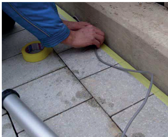
2 Po odparowaniu podkładu w szczelinie ułożyć sznur dylatacyjny Sopro PER 567
