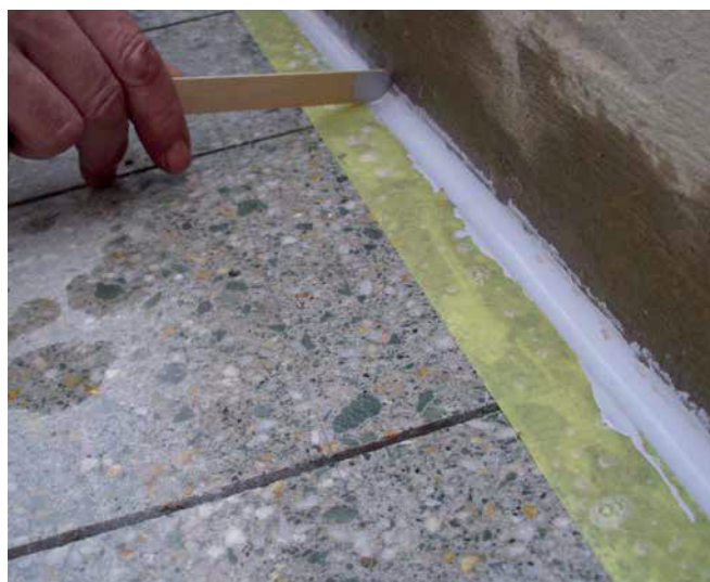
4 Powierzchnię spoiny wygładzić przy pomocy odpowiedniej kształtki, zwilżonej Sopro GM 026.
