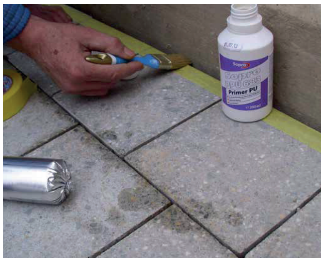
1 Podkład Sopro PPU 683 nanieść przy pomocy pędzla na krawędzie zabezpieczone taśmą samoprzylepną.
