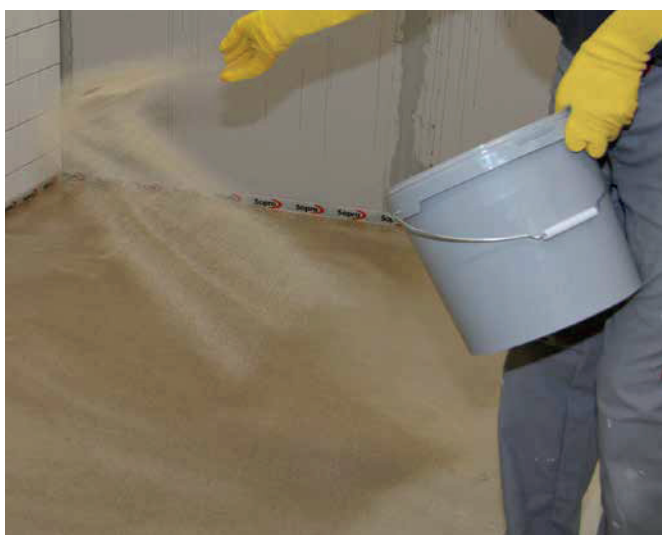
9 ... i obficie obsypać piaskiem kwarcowym Sopro QS 507 lub Sopro QS 511
