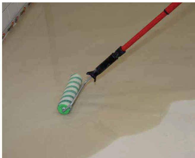
8 ... rozprowadzić przy pomocy odpornego na działanie żywicy wałka futrzanego, dokładnie nasycając powierzchnię ...
