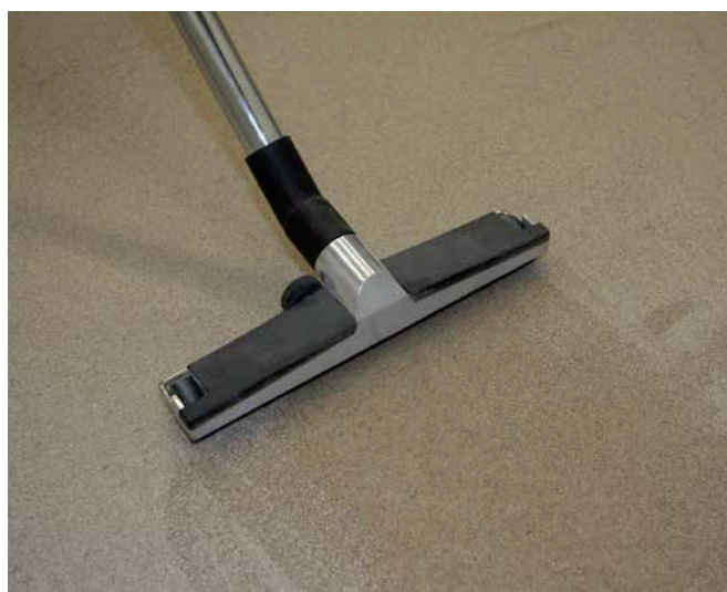
10 Nadmiar piasku usunąć po całkowitym wyschnięciu preparatu Sopro EPG 522 (po ok. 24 godzinach) przy pomocy odkurzacza przemysłowego lub miotły
