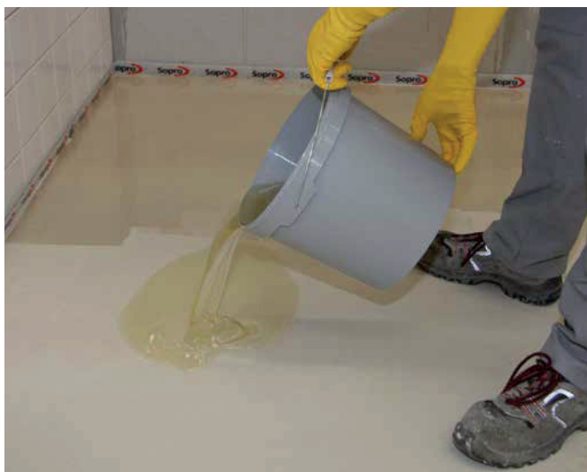
7 Sopro EPG 522 wylać na podłogę ...
