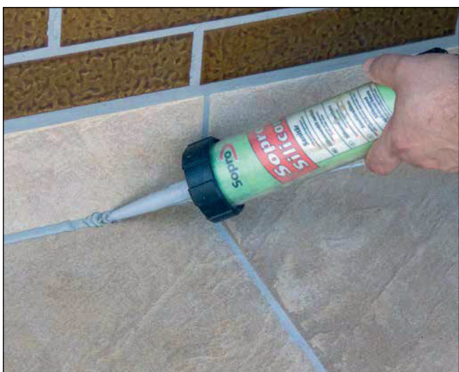
23 Spoiny dylatacyjne i spoiny narożne wypełnić silikonem Sopro Silikon.
