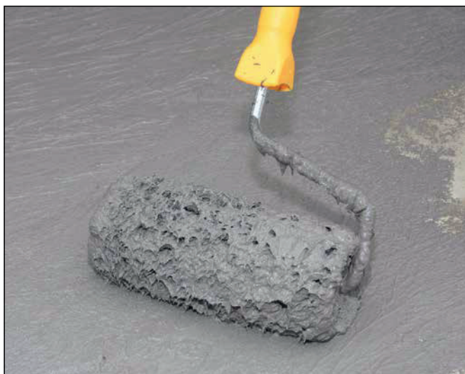
13 Masę uszczelniającą Sopro TDS 823 można nakładać również przy pomocy wałka malarskiego.
