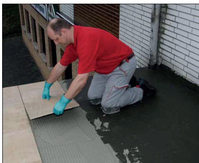
18 Płyty ułożyć na świeżej zaprawie klejowej, przesunąć i ustawić w ostatecznym położeniu.
