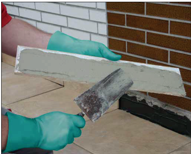
19 Na spodnią stronę odpowiednio dociętej płytki cokołowej nanieść elastyczną zaprawę Sopro (np. Sopro No.1 400, Sopro FKM XL 444) ...
