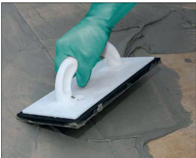
21 Po związaniu elastycznej zaprawy klejowej Sopro okładzinę zaspoinować zaprawą fugową Sopro (np. Sopro DF 10® lub Sopro FL).
