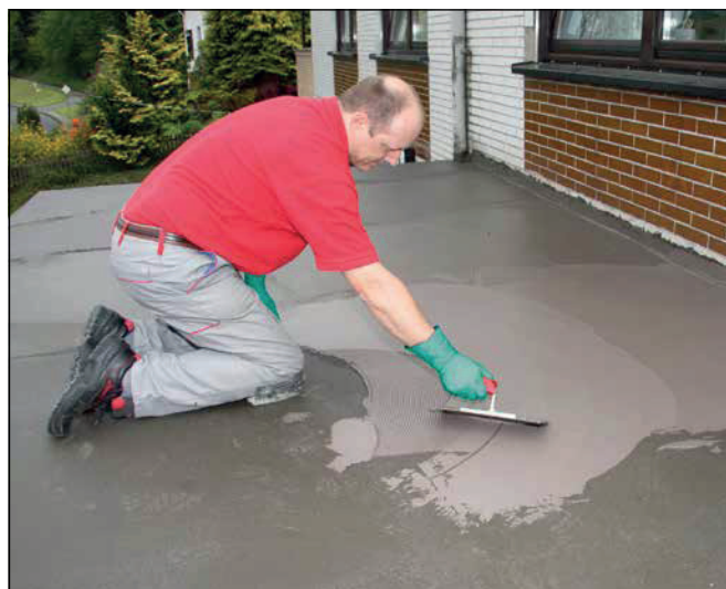
14 Nałożenie drugiej warstwy uszczelnienia następuje już po 2 godzinach na przeschniętą pierwszą warstwę ...
