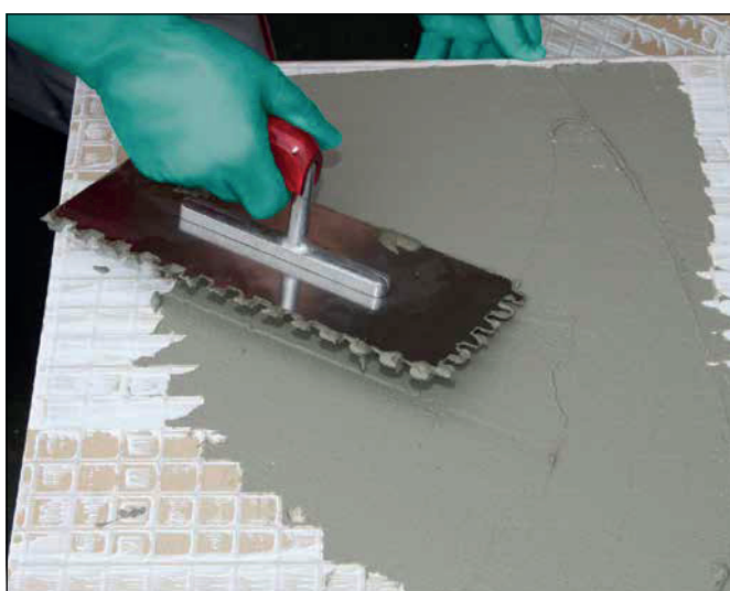
17 Zastosowanie metody kombinowanej przy klejeniu okładziny zależy od formatu i właściwości spodniej części płytki oraz służy osiągnięciu pełnego przylegania okładziny do podłoża.
