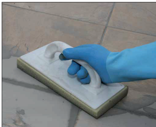
22 Po lekkim związaniu zaprawy fugowej Sopro (fuga tężeje w szczelinach spoinowych), zafugowaną okładzinę zmyć do czysta.
