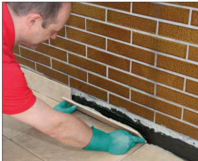
20 ... i osadzić płytkę w obszarze cokolu.
