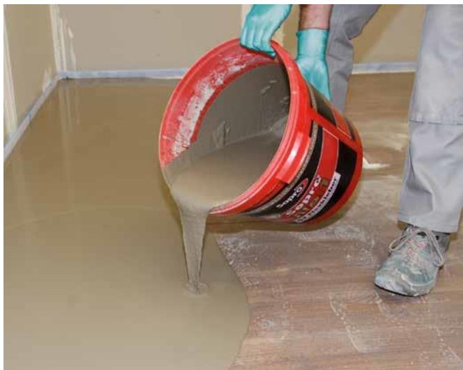
7 Szpachlowanie nierówności za pomocą wylewki samopoziomującej Sopro FLOOR WS 3.70 extreme.
