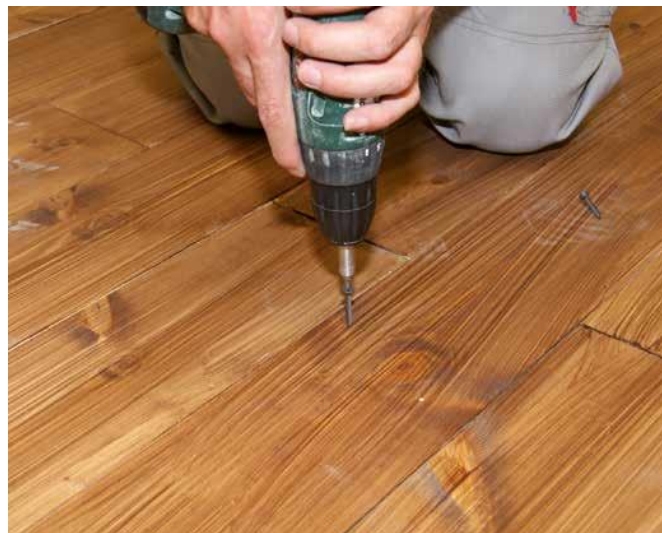
2 Sprężynujące deski najpierw są mocowane do konstrukcji nośnej, przy pomocy wkrętów do drewna.
