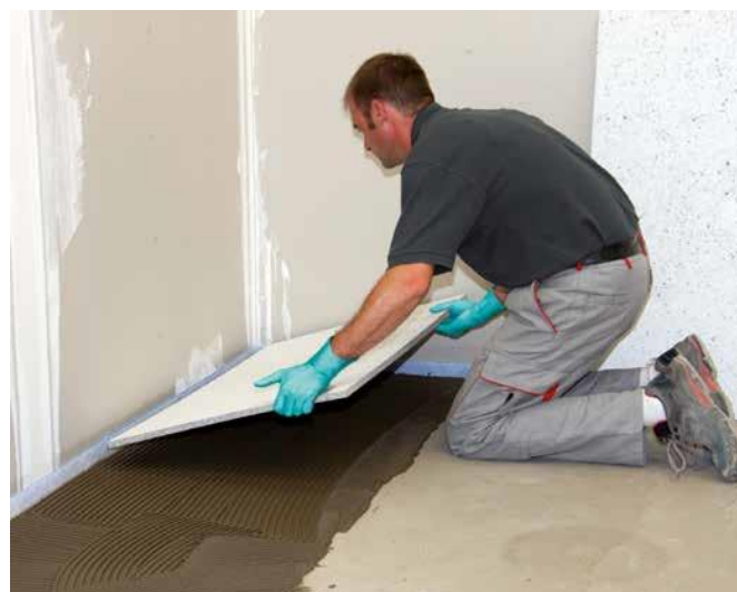
10 Układanie płyt izolacyjnych Sopro FDP 558 na świeżej zaprawie klejowej.
