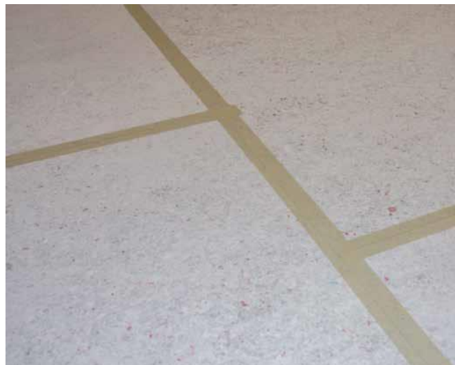
14 Dla wyeliminowania mostków akustycznych, spowodowanych zaprawą klejową, łączenia płyt zakleja się papierową taśmą klejącą.
