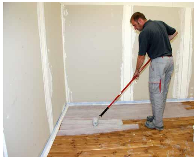
6 Na powierzchnię podłogi drewnianej nanieść preparat gruntujący do podłoży niechłonnych Sopro HPS 673.
