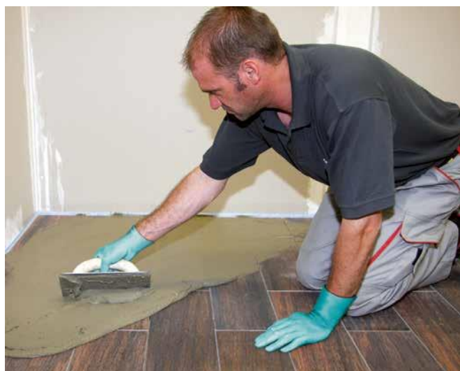
17 Fugowanie płytek fugą elastyczną np. Sopro DF 10 o .
