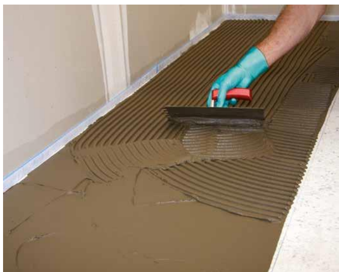
15 Na płyty izolacyjne Sopro FDP 558 do układania okładziny ceramicznej nałożyć elastyczną zaprawę klejową np. Sopro No.1 400 przy pomocy pacy zębatej.
