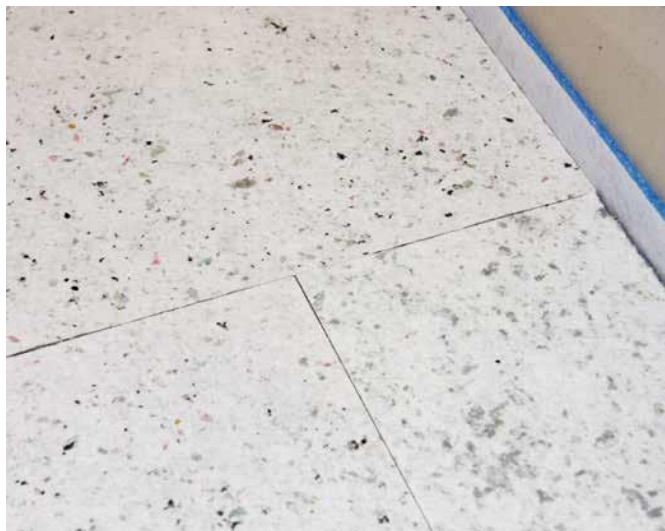
13 Układanie płyt następuje bezspoinowo. Krawędzie płyt przylegają do siebie.
