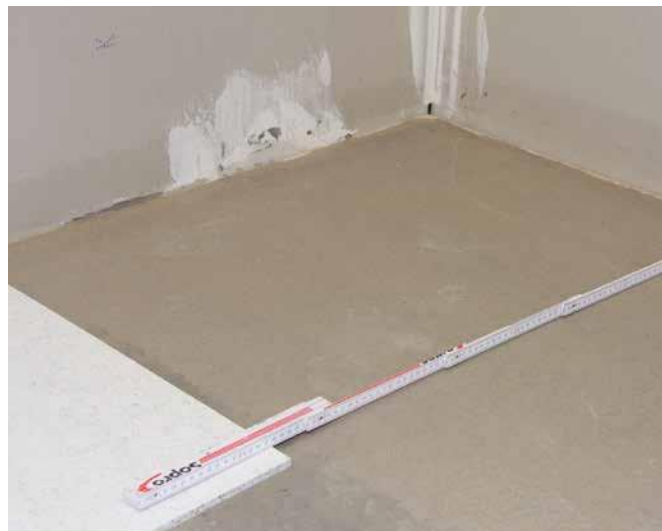
2 Przed układaniem płyt izolacyjnych wykonać dokładny pomiar pomieszczenia.
