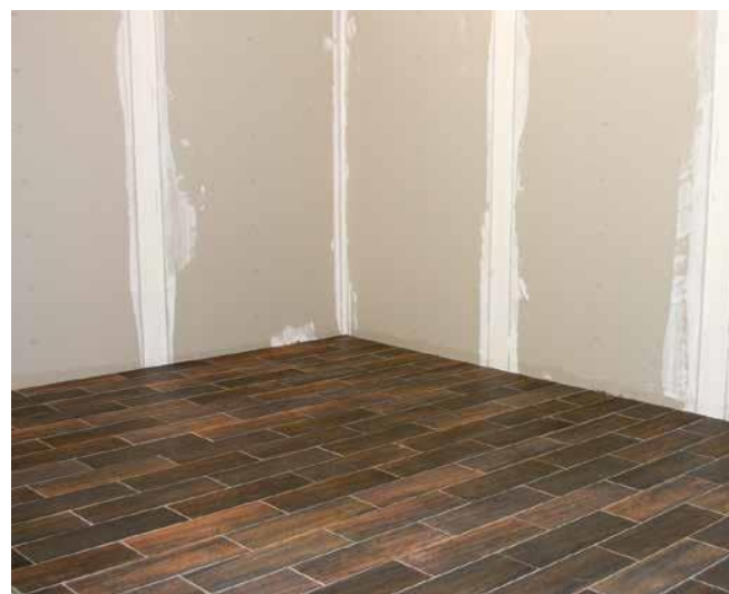
18 Gotowa okładzina ceramiczna na drewnianym podłożu.
