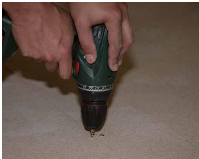
1 Przed układaniem płyt Sopro FDP 558 podłoże (np. płyty wiórowe) przymocować do konstrukcji nośnej.
