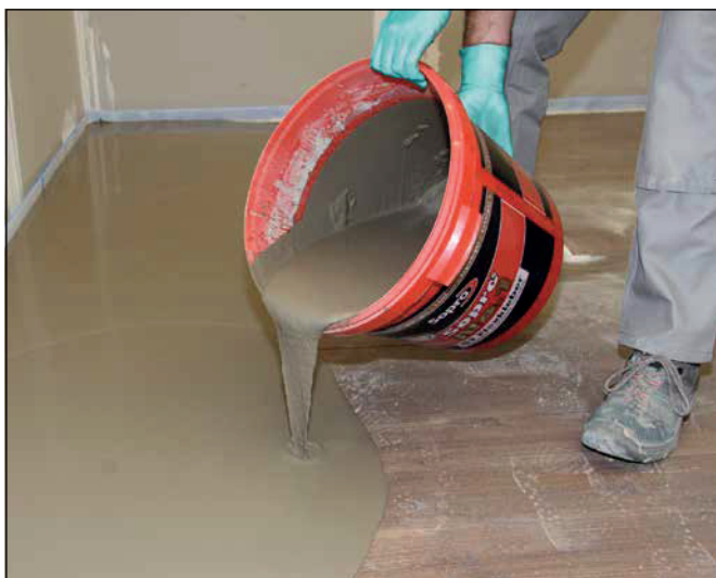
7 Szpachlowanie nierówności za pomocą szpachli samopoziomującej Sopro FAS 551.
