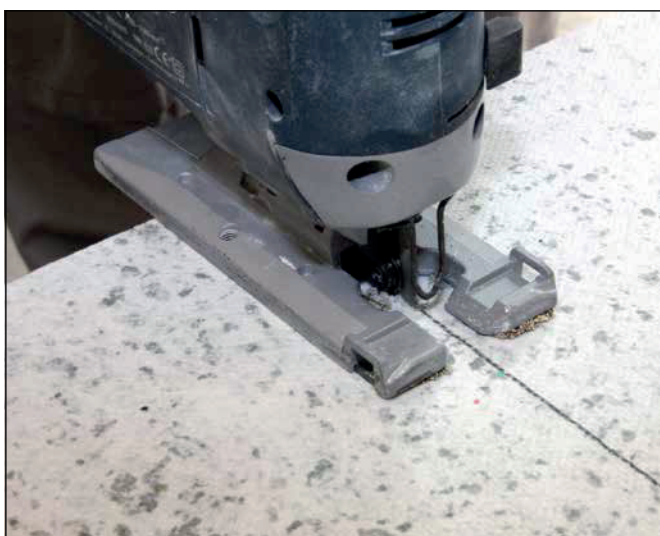
11 Obróbka i cięcie płyt izolacyjnych Sopro FDP 558 jest możliwe np. przy użyciu wyrzynarki.
