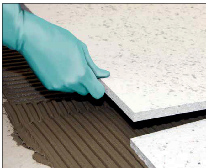
12 Płyty izolacyjne Sopro FDP 558 w prosty sposób układane są obok siebie.
