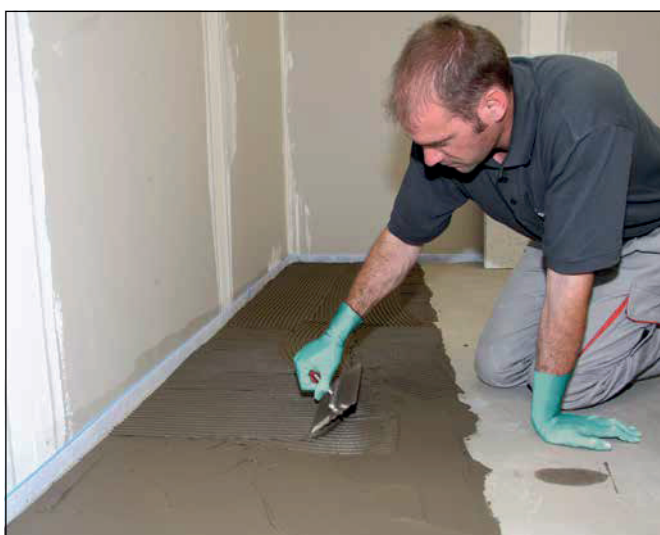
9 Jeżeli podłoże drewniane jest równe, bezpośrednio na preparat gruntujący Sopro HPS 673 nałożyć zaprawę klejową np. Sopro VF XL 413 w celu przygotowania powierzchni pod płyty izolacyjne Sopro FDP 558.
