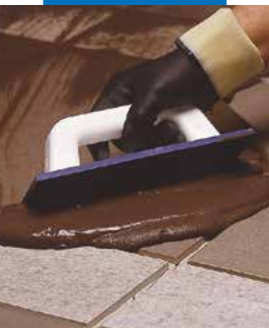
Rozprowadzanie zaprawy Ultracolor Plus na podłodze przy użyciu gumowej pacy
