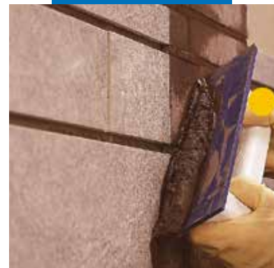
Nanoszenie zaprawy Ultracolor Plus przy użyciu gumowej pacy
