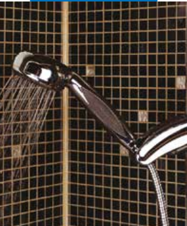
Przykład wykonania okładziny z mozaiki szklanej w kabinie prysznicowej z zastosowaniem Ultracolor Plus
