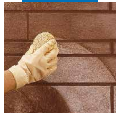
Czyszczenie i profilowanie fug gąbką
