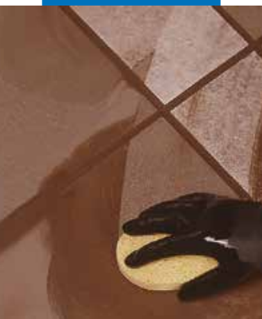
Czyszczenie i profilowanie fug gąbką
